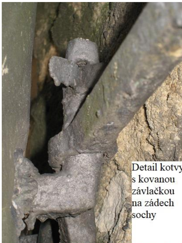
Detail znečištění a postupující, už dosti silné koroze.
